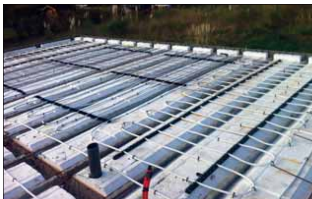
5. Pose des panneaux treillis soudés
