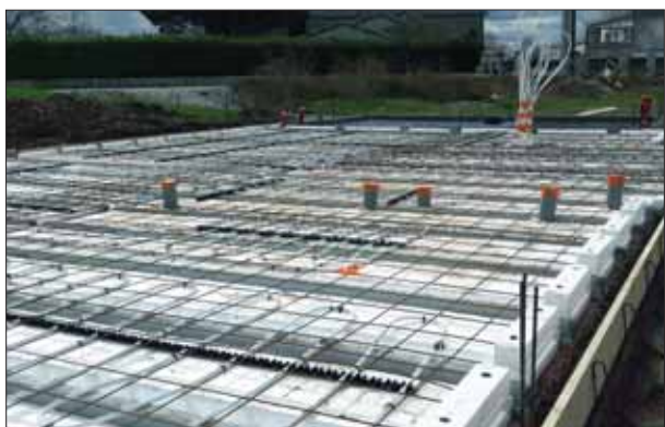
5. Pose des panneaux treillis soudés
