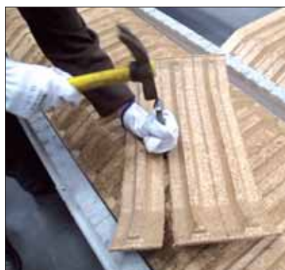
Coupe au burin ou au marteau (sécable)
