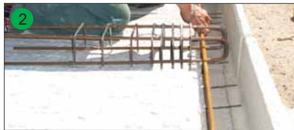
Mise en place des armatures du chaînage
