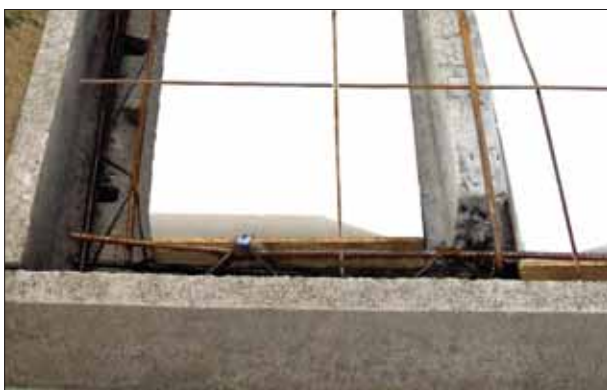
Plancher Hourdis Seacbois Rupteur Partiel : Stoptherm ES
