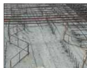
Pose des armatures sur écarteurs
