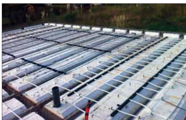
5. Pose des panneaux treillis soudés
