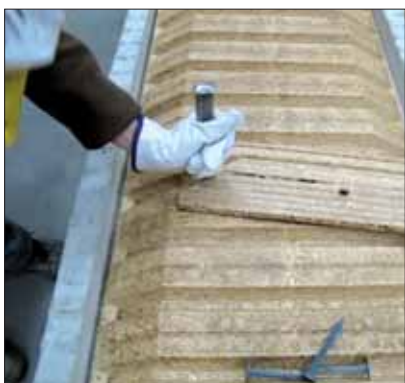
Séparation du tympan pour rupteur ES
