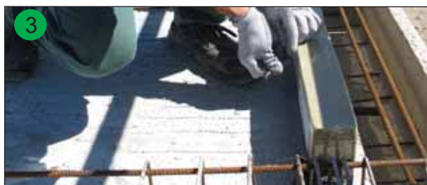
Positionnement et fixation du bloc isolant
