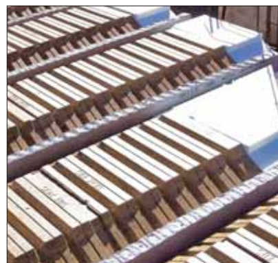
Rupture thermique en zone biaisée avec le Stoptherm ES (Seacbois)
