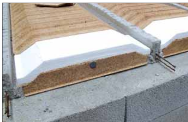
Plancher EBS Rupteur Partiel : Stoptherm ES
