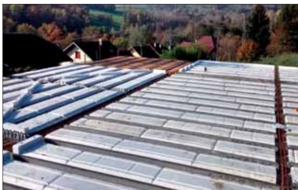
3. Pose des circuits chauffants
