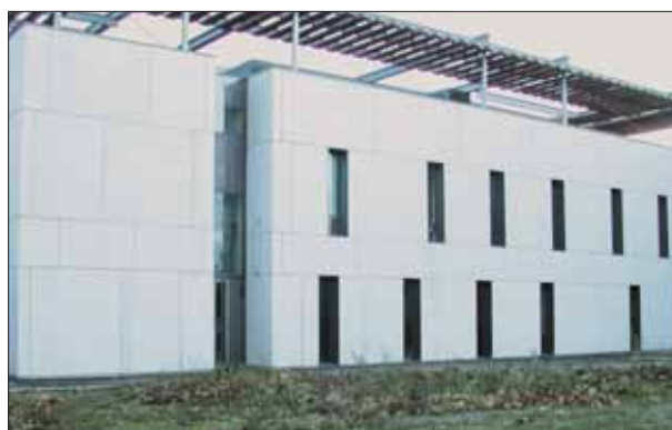
Entreprise BALMELLE - Chantier : Centre Multimédia Albi Architecte : CABINET BRUNERI
