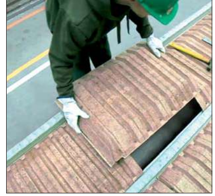
Ajustement dans sa longueur Toujours couper le bouchon sur l'EBS d'ajustement qui vient en recouvrement sur les 2 autres
