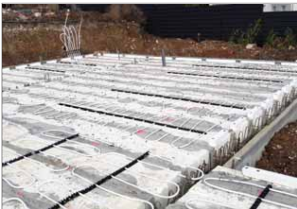
Système conforme au NF DTU 65.14 P2
