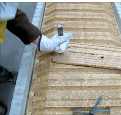
Séparation du tympan pour rupteur ES
