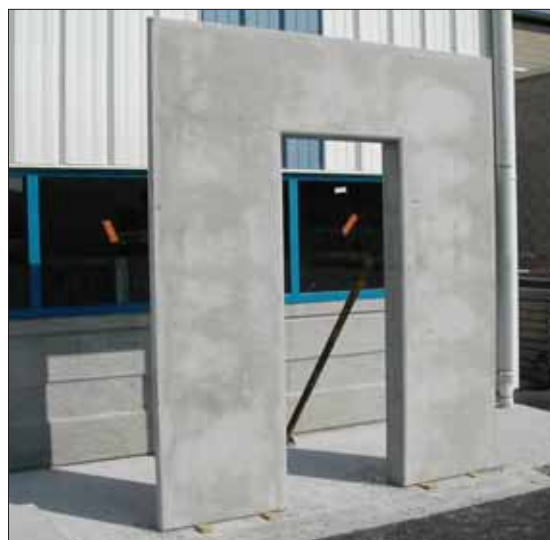
Coffrage avec chant en béton de fibre
