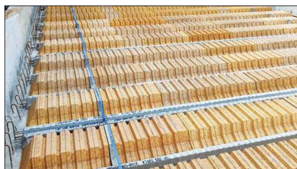
Temps de pose optimisé Panneaux de 2,00 ml de large et jusqu'à 8,00 ml de portée 1 file d'étais jusqu'à 6,50 m
