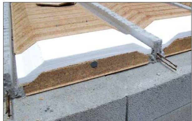
Plancher EBS Rupteur Partiel : Stoptherm ES
