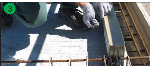
Positionnement et fixation du bloc isolant
