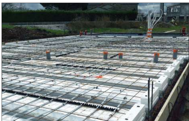
5. Pose des panneaux treillis soudés
