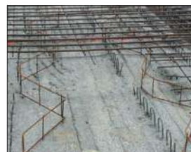
Pose des armatures sur écarteurs
