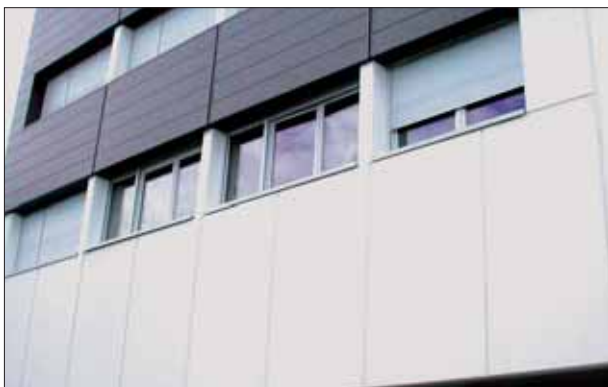
Entreprise GBMP - Chantier : Résidence Pierre Garrigues Toulouse Architecte : MARTINIE
