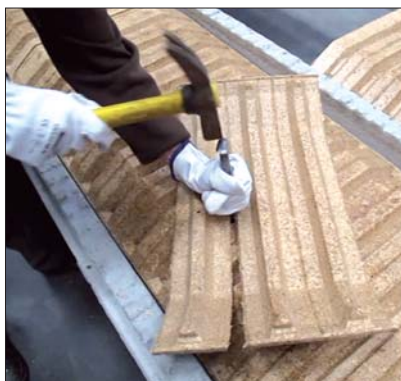
Coupe au burin ou au marteau (sécable)
