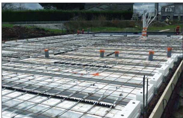
5. Pose des panneaux treillis soudés
