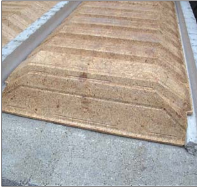
Pose de l'EBS en bout de travée avec bouchon incorporé Toujours commencer par les extrémités avec les bouchons posés sur les arases
