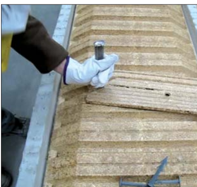
Séparation du tympan pour rupteur ES
