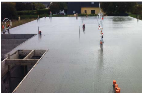
6. Coulage de la dalle de compression du plancher Seacwatt-Clima
