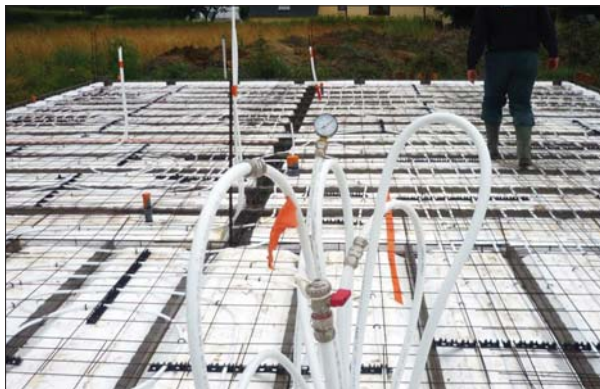
4. Mise en pression des circuits à l'air comprimé
