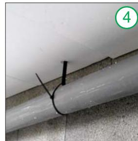
Passez le collier de supportage dans la fente prévue à cet effet au bout de la tige. Puis mettre le collier autour du tuyau en serrant le collier pour fixer.
