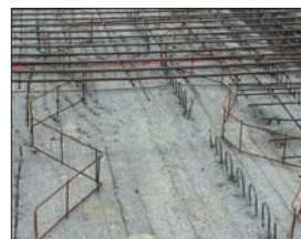
Pose des armatures sur écarteurs
