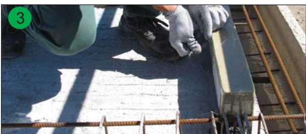
Positionnement et fixation du bloc isolant
