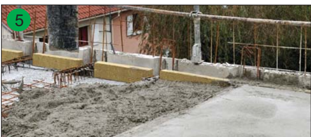
Coulage de la dalle de compression
