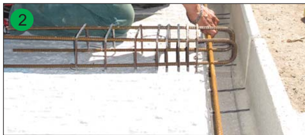
Mise en place des armatures du chaînage
