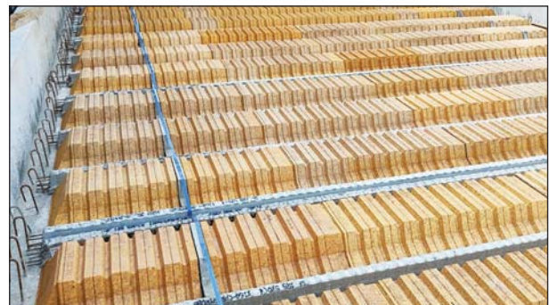
Temps de pose optimisé Panneaux de 2,00 ml de large et jusqu'à 8,00 ml de portée 1 file d'étais jusqu'à 6,50 m
