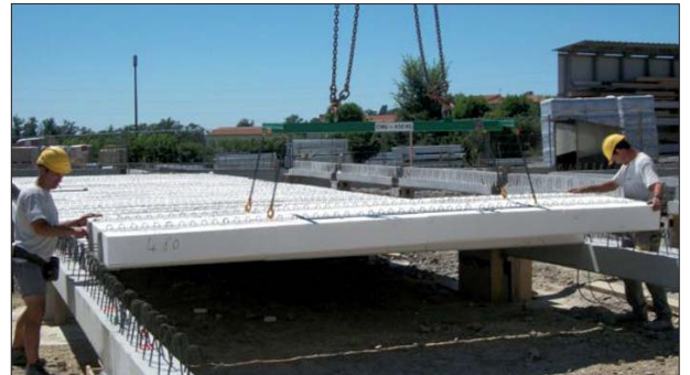
Un petit palonnier très léger permet de poser les modules deux par deux sur arase, le réglage final se fait à la main
