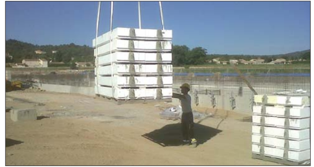
Sangles de levage intégrées pour un déchargement plus rapide et un stockage près du lieu de pose
