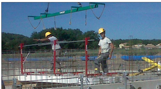
Le Seacisol permet de se déplacer en toute sécurité pendant la pose et le coulage
