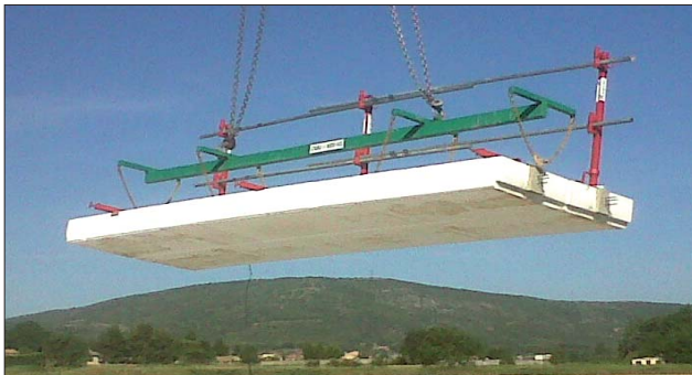
Un petit palonnier très léger permet de poser les modules deux par deux sur arase, le réglage final se fait à la main
