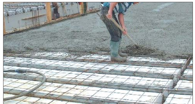
Le Seacisol permet de se déplacer en toute sécurité pendant la pose et le coulage
