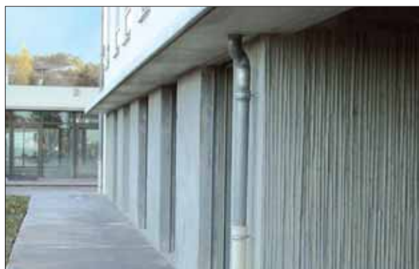
Entreprise EIFFAGE/BILSKI - chantier : EHPAD Carmaux Architecte : SCP ESPAGNO & MILANI
