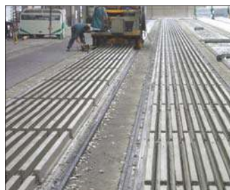
Fabrication Poutrelle GF
