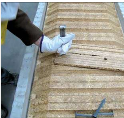
Séparation du tympan pour rupteur ES
