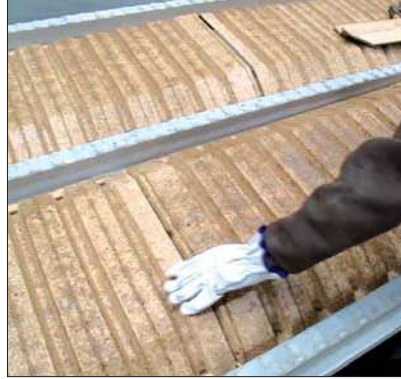
Emboîtement de deux EBS sans coupe du bouchon
