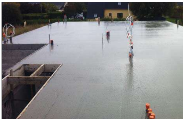
6. Coulage de la dalle de compression du plancher Seacwatt-Clima
