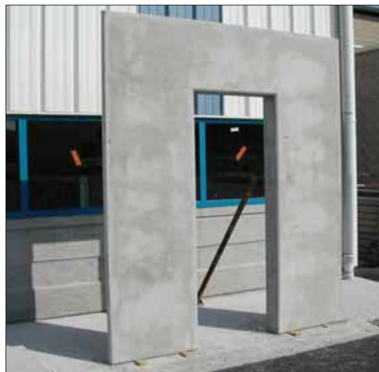
Coffrage avec chant en béton de fibre
