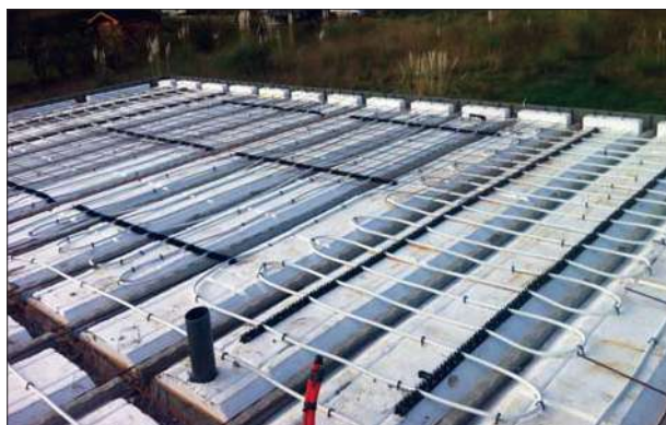
5. Pose des panneaux treillis soudés
