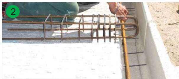
Mise en place des armatures du chaînage
