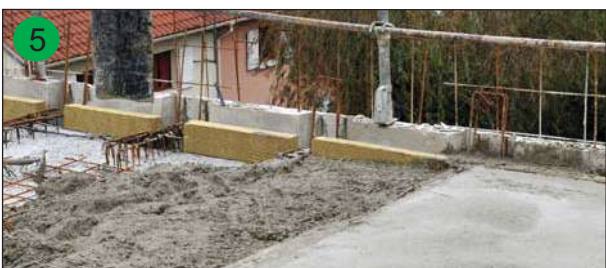
Coulage de la dalle de compression
