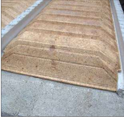
Pose de l'EBS en bout de travée avec bouchon incorporé Toujours commencer par les extrémités avec les bouchons posés sur les arases
