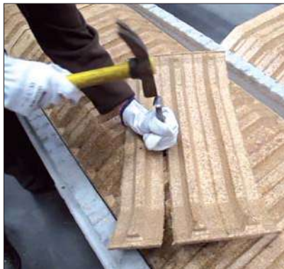
Coupe au burin ou au marteau (sécable)
