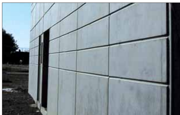
Entreprise CAMPENON BERNARD INDUSTRIE - Chantier : Caserne Militaire Istres Maître d'oeuvre /Architecte : Ministère de la défense
