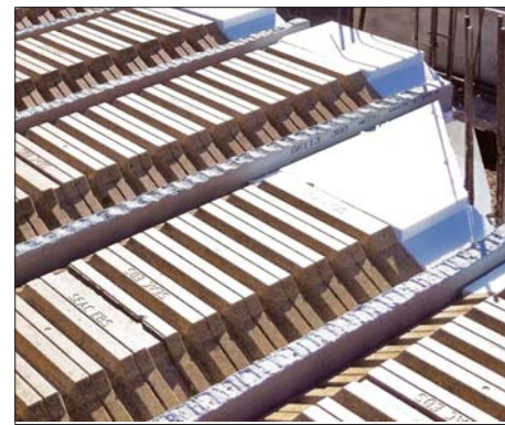
Rupture thermique en zone biaisée avec le Stoptherm ES (Seacbois)
