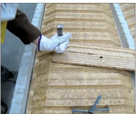
Séparation du tympan pour rupteur ES
