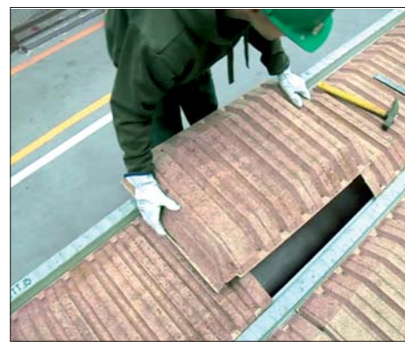
Ajustement dans sa longueur. Toujours couper le bouchon sur l'EBS d'ajustement qui vient en recouvrement sur les 2 autres
