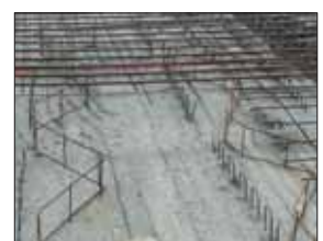
Pose des armatures sur écarteurs
