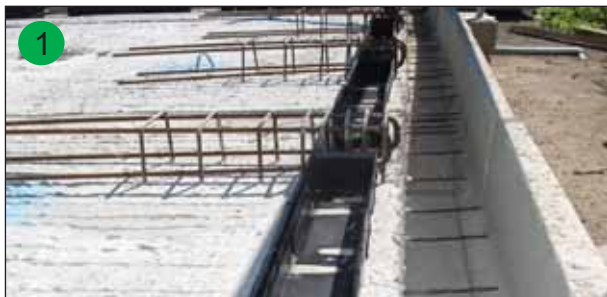
Mise en place des armatures du chaînage
