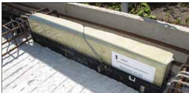
Mise en place du bloc isolant
