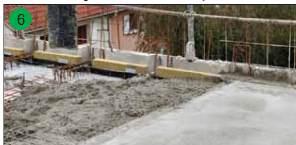
Coulage de la dalle de compression
