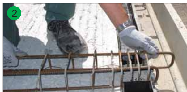
Positionnement et fixation du bloc isolant
