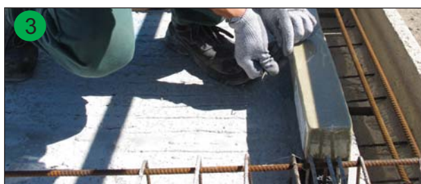
Positionnement et fixation du bloc isolant
