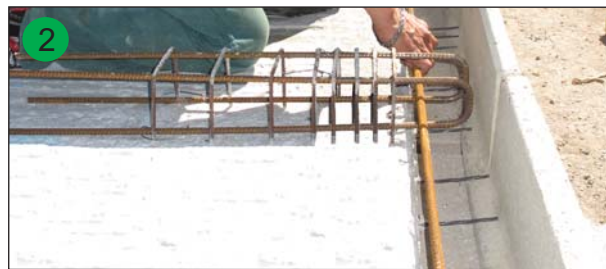
Mise en place des armatures du chaînage
