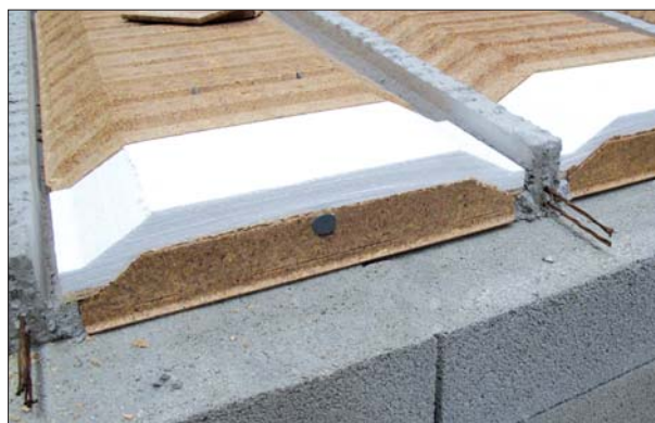
Plancher EBS Rupteur Partiel : Stoptherm ES
