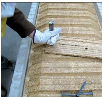
Séparation du tympan pour rupteur ES
