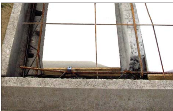
Plancher Hourdis Seacbois Rupteur Partiel : Stoptherm ES
