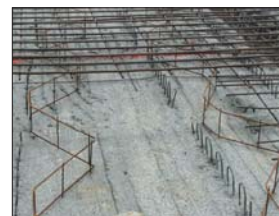
Pose des armatures sur écarteurs
