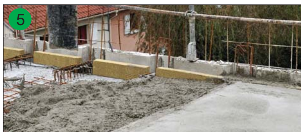
Coulage de la dalle de compression
