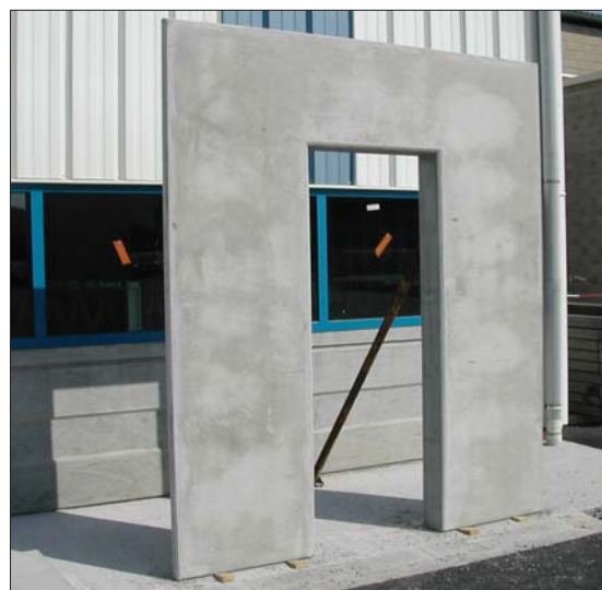
Coffrage avec chant en béton de fibre
