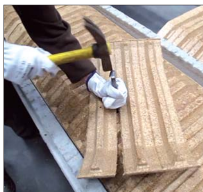
Coupe au burin ou au marteau (sécable)
