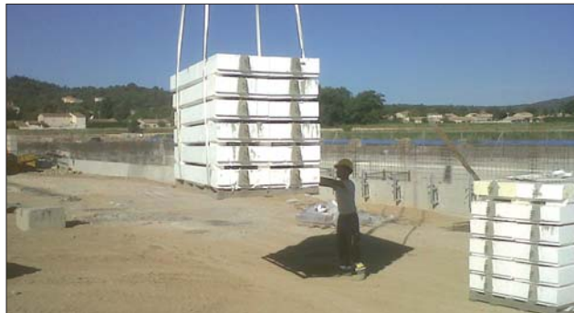
Sangles de levage intégrées pour un déchargement plus rapide et un stockage près du lieu de pose
