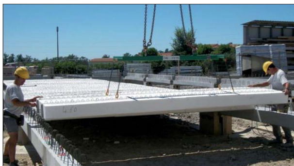
Un petit palonnier très léger permet de poser les modules deux par deux sur arase, le réglage final se fait à la main
